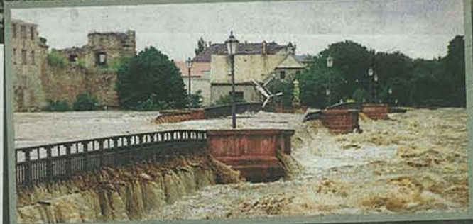
Die Mulde zerstörte am 13. August 2002 die historische Pöppelmannbrücke
