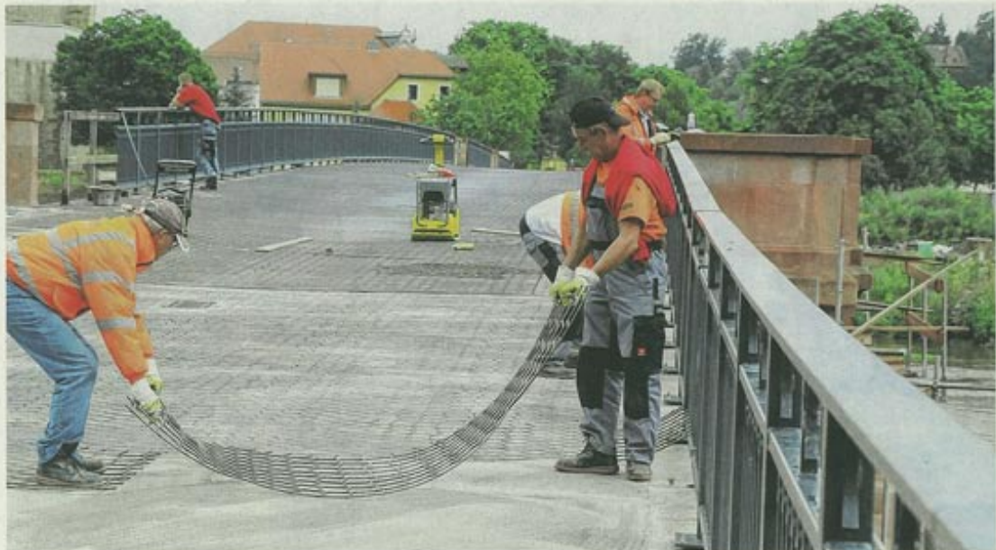
Optische Täuschung: Bei wechselhaftem Wetter brachten die Bauarbeiter gestern eine Schicht aus Gussasphalt auf die neue Pöppelmannbrücke. Ein Gitter aus Metall und eine Rüttelplatte reichen aus, um dem Belag eine Pflastersteinoptik aufzustempeln. Fotos: Andreas Röbe
