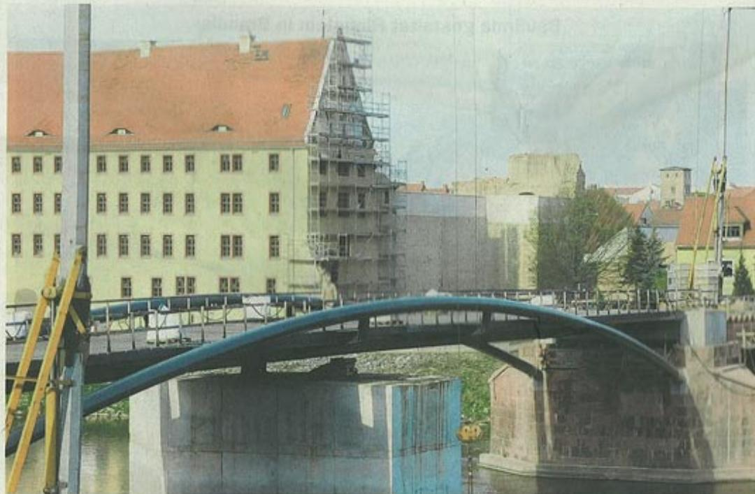
Blick auf die Pöppelmannbrücke: Noch thront der aus Beton gegossene Behelfspfeiler unter der Stahlkonstruktion. Er soll aber kurz vor Fertigstellung der Brücke weggerissen werden. Dann hat die Mulde freien Fluss. Foto: Andreas Röse
