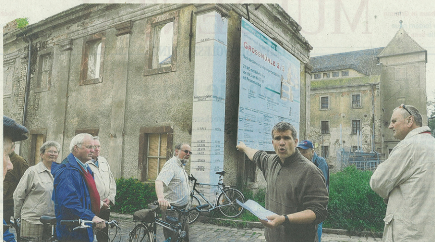
Problem an der Großmühle: Man weiß noch nicht, wie die Ruine in die Hochwasserschutzmauer integriert werden könnte, zeigt Oberbürgermeister Matthias Berger. Foto: Frank Schmitt
