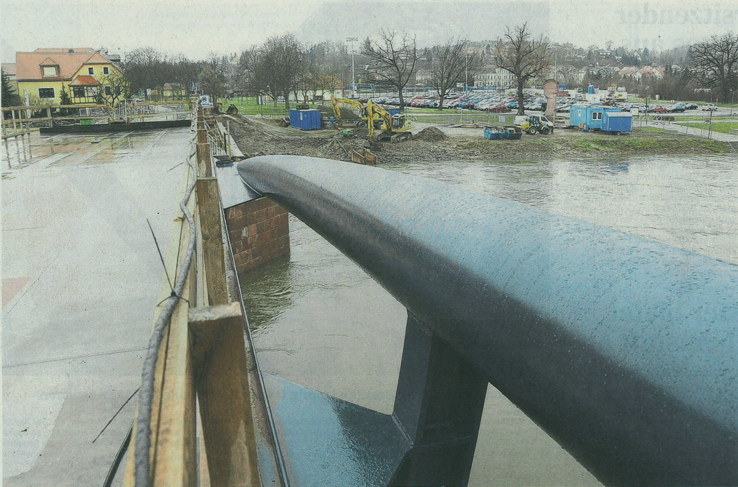
Stille am Bau: Noch hat Mutter Natur die Baustelle an der Pöppelmannbrücke nicht wieder freigegeben.
