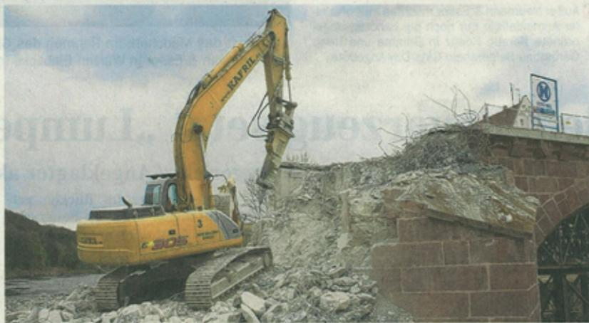
Nur noch Hülle: Der alte Brückenpfeiler wird ausgehöhlt und innen mit strahlenförmig in die Erde gebohrten so genannten Verpresspfählen stabilisiert.
