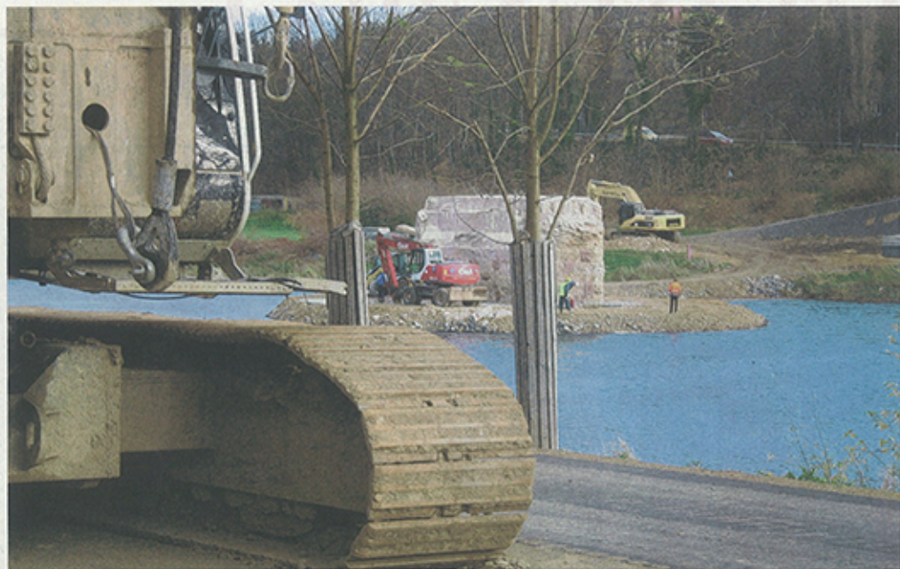
Zwei Baustellen auf engem Raum: In der Mulde ist der teilweise abgebrochene Pfeiler der Pöppelmannbrücke zu sehen, der erst nach dem Neubau komplett verschwindet. Im Vordergrund steht am Schloss schweres Baugerät für den nächsten Abschnitt des Baus der Hochwasserschutzmauer. Foto: André Neumann
