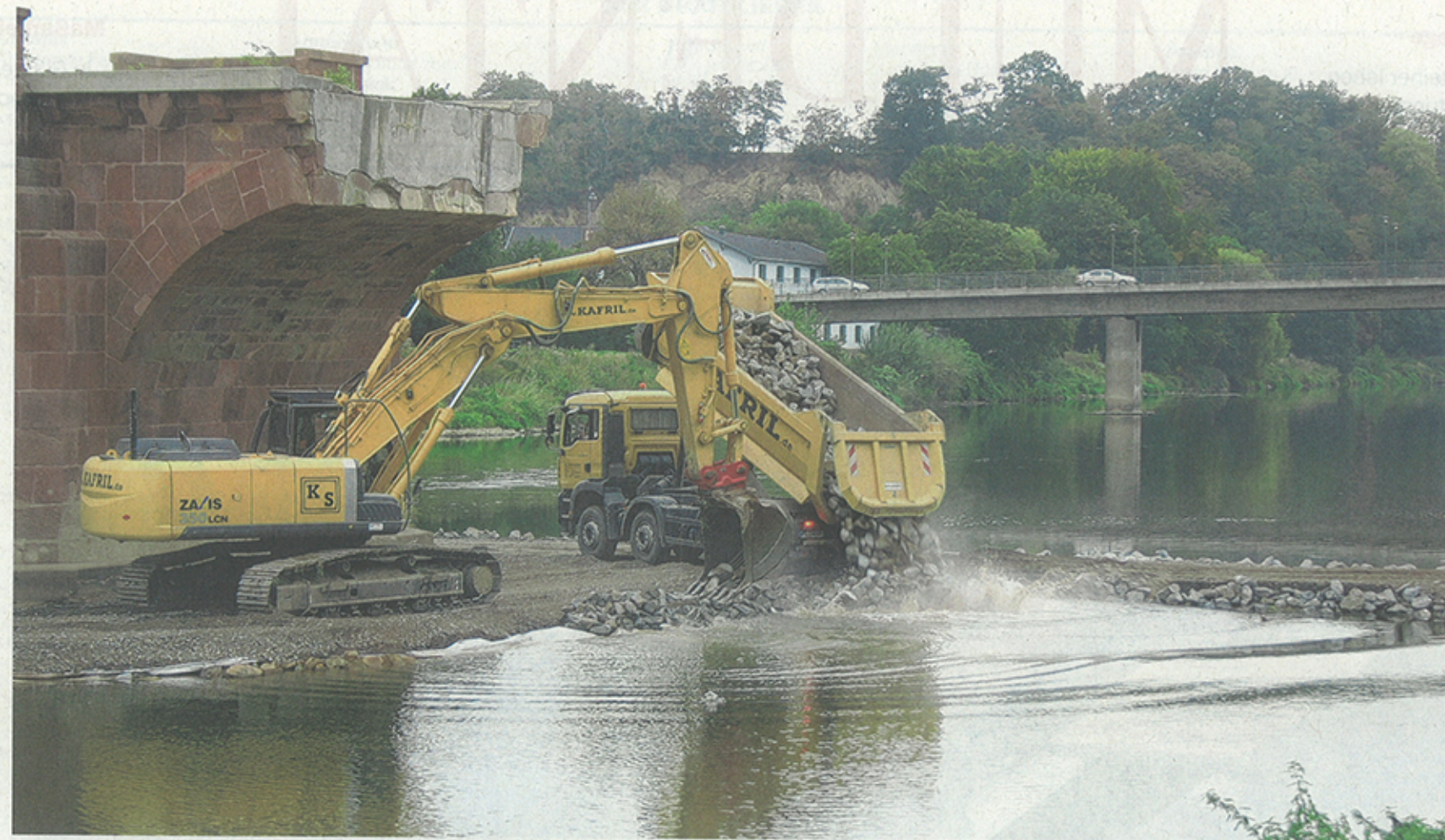
Abriss wird vorbereitet: Baggerfahrer Matthias Böhme und Lasterfahrer Jürgen Krause von der Firma Kafрил vollendeten gestern die Baustraße vom östlichen Ufer zum und um den in der Mitte der Mulde stehenden Pfeiler.
