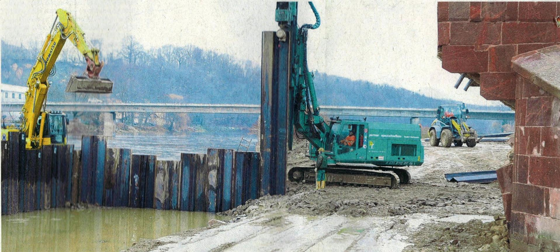
Die **Brückenbaustelle in Grimma** zieht auf die Westseite der Mulde. Wie zuvor auf der Stadtseite wird jetzt hier mit einer Spundwand aus Metallbohlen das Baufeld trocken gelegt – für
