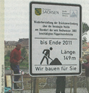
Ungeliebte Bautafel: So steht sie eigentlich an Autobahnen.
