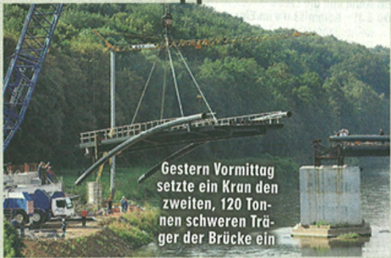
Gestern Vormittag setzte ein Kran den zweiten, 120 Tonnen schweren Träger der Brücke ein
