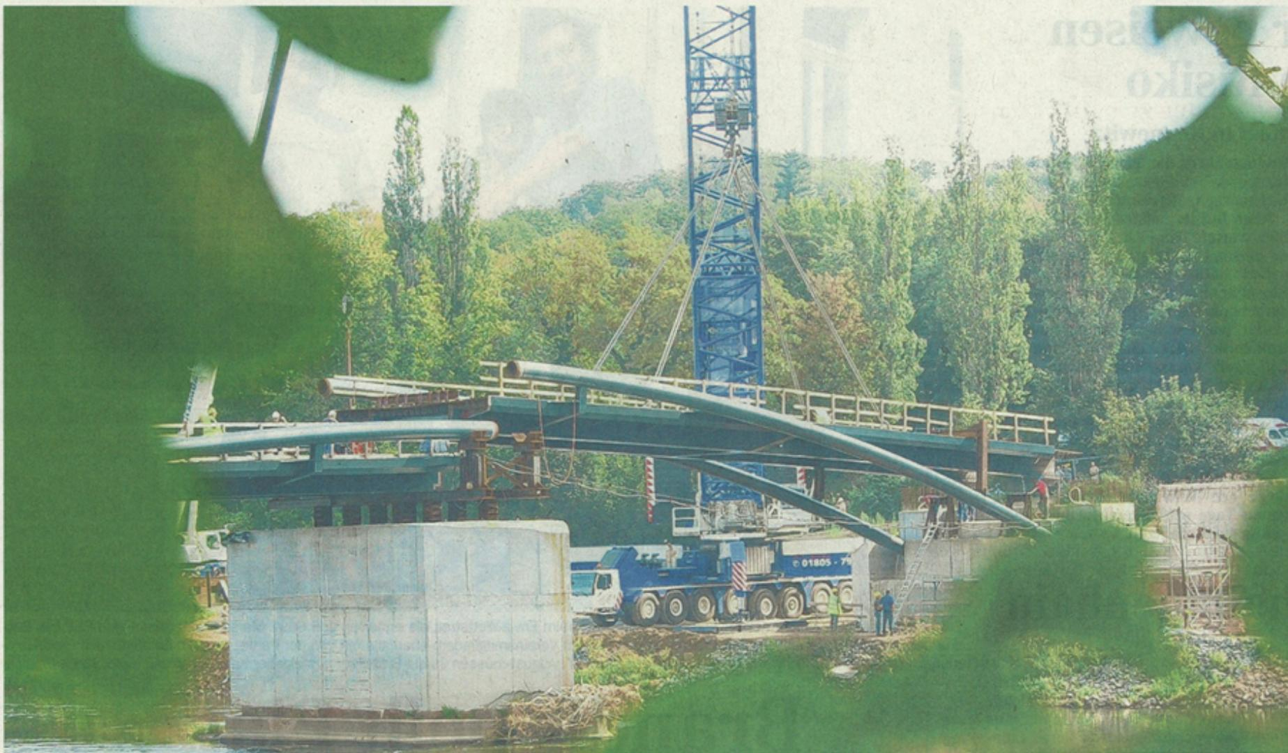
Brückenschlag: Seit gestern ist der Wiederaufbau der Pöppelmannbrücke zumindest optisch komplett: Ein großer Kran brachte die zweite Hälfte des neuen Spannwerkes am Vormittag in seine Position. Fotos: Roger Dietze
